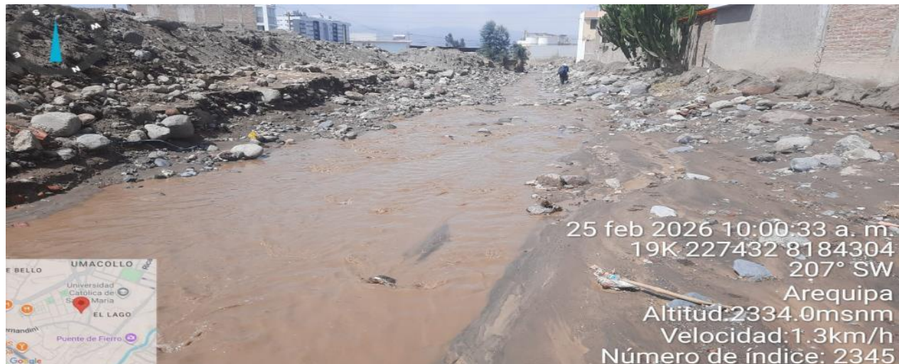
IMAGEN 01: SE OBSERVA EL DESBORDE Y LA EROSION EN LA QUEBRADA CHULLO, SE REQUIERE DE LIMPIEZA, DESCOLMATACION Y PROTECCION CON
