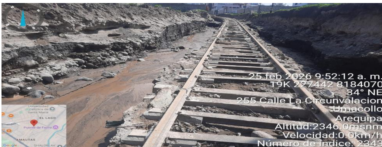
IMAGEN 02: SE OBSERVA LA COLMATACION EN EL TRAMO PRODUCTO DEL DESBORDE EROSIONANDO LA VIA FERREA, SE REQUIERE DE INTERVENCION
